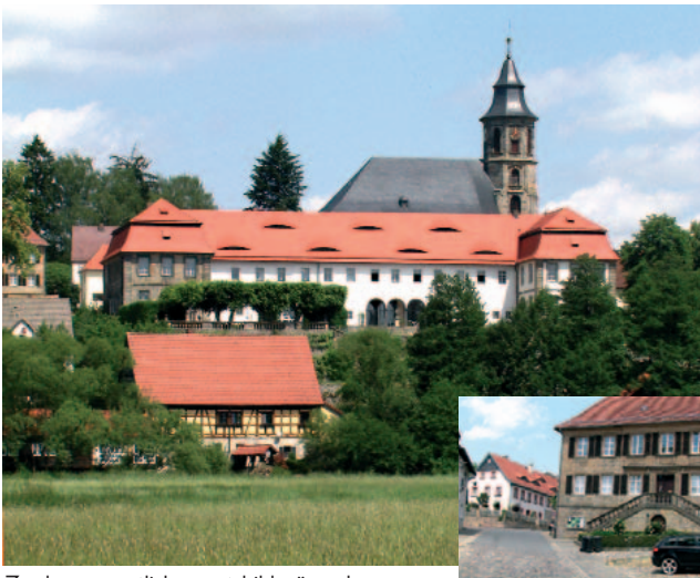
Zu den wesentlichen ortsbildprägenden Gebäuden zählen das Schloss, die Markgrafenkirche und das Pfarrhaus (kleines Photo), aber auch das sanierte Anwesen Müller (kleines Photo).
