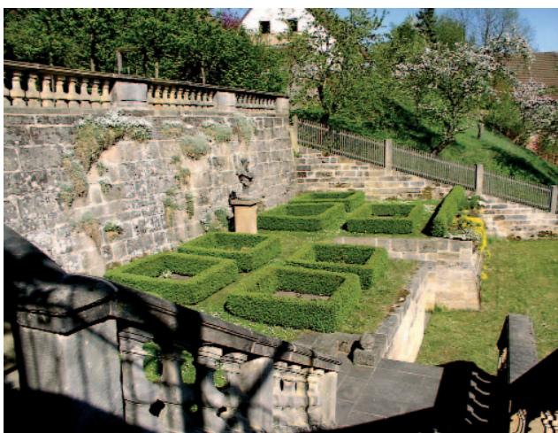
Die Kombination aus formaler und baulicher Gestaltung findet sich auf den verschiedenen Ebenen der Terrassen.
