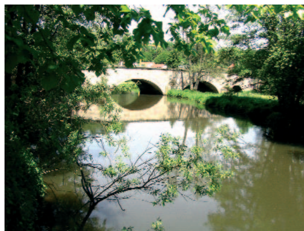
Die historische Mainbrücke verbindet Alt- und Neudrossenfeld.
