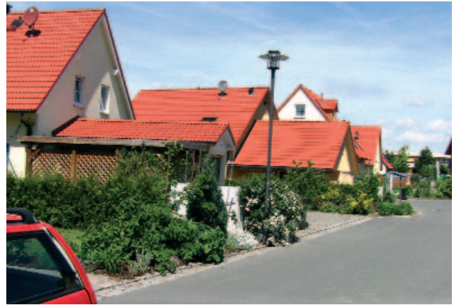
Ökologisches Baugebiet „Am Weidenrain“: Heizen mit Wärmepumpen, Regenwassernutzung durch Zisternen.
