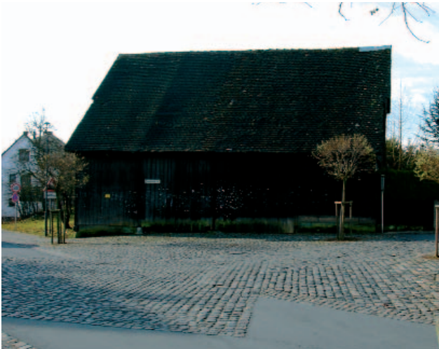
Die sanierungsbedürftige Scheune am Rotdornplatz liegt im Sanierungsgebiet und würde sich hervorragend als Standort für die Obstpresse anbieten.
