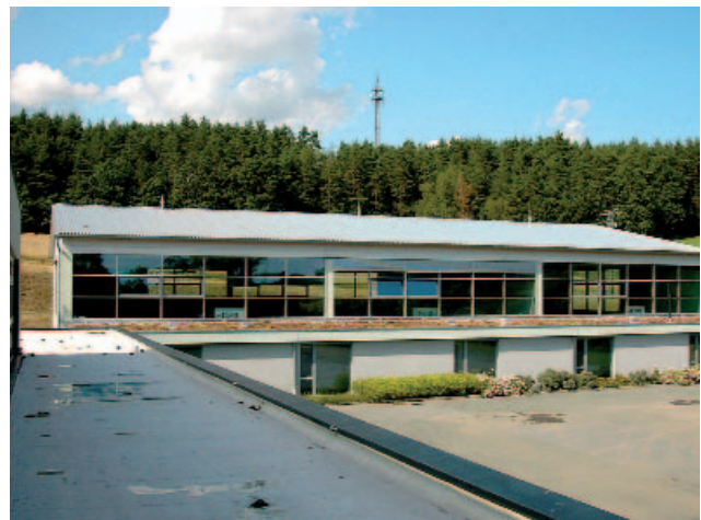
Die neue Dreifachturnhalle neben der Schule mit großzügiger Seitenaufglasung und Dachbegrünung im Bereich der Umkleideräume.
