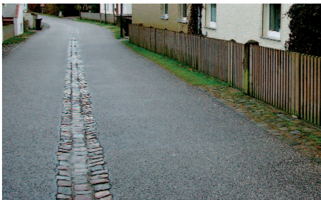
Ledergasse nach der Städtebauförderung mit Gussasphalt und Mittelentwässerung, Seitengrün und Lattenzaun.
