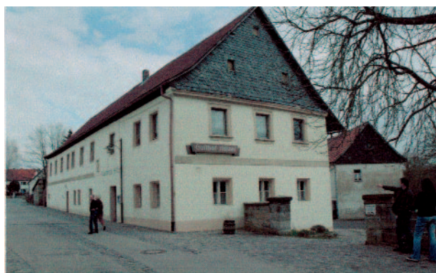
Zu sanierende Gaststätte mit Tanzsaal für Kulturveranstaltungen
