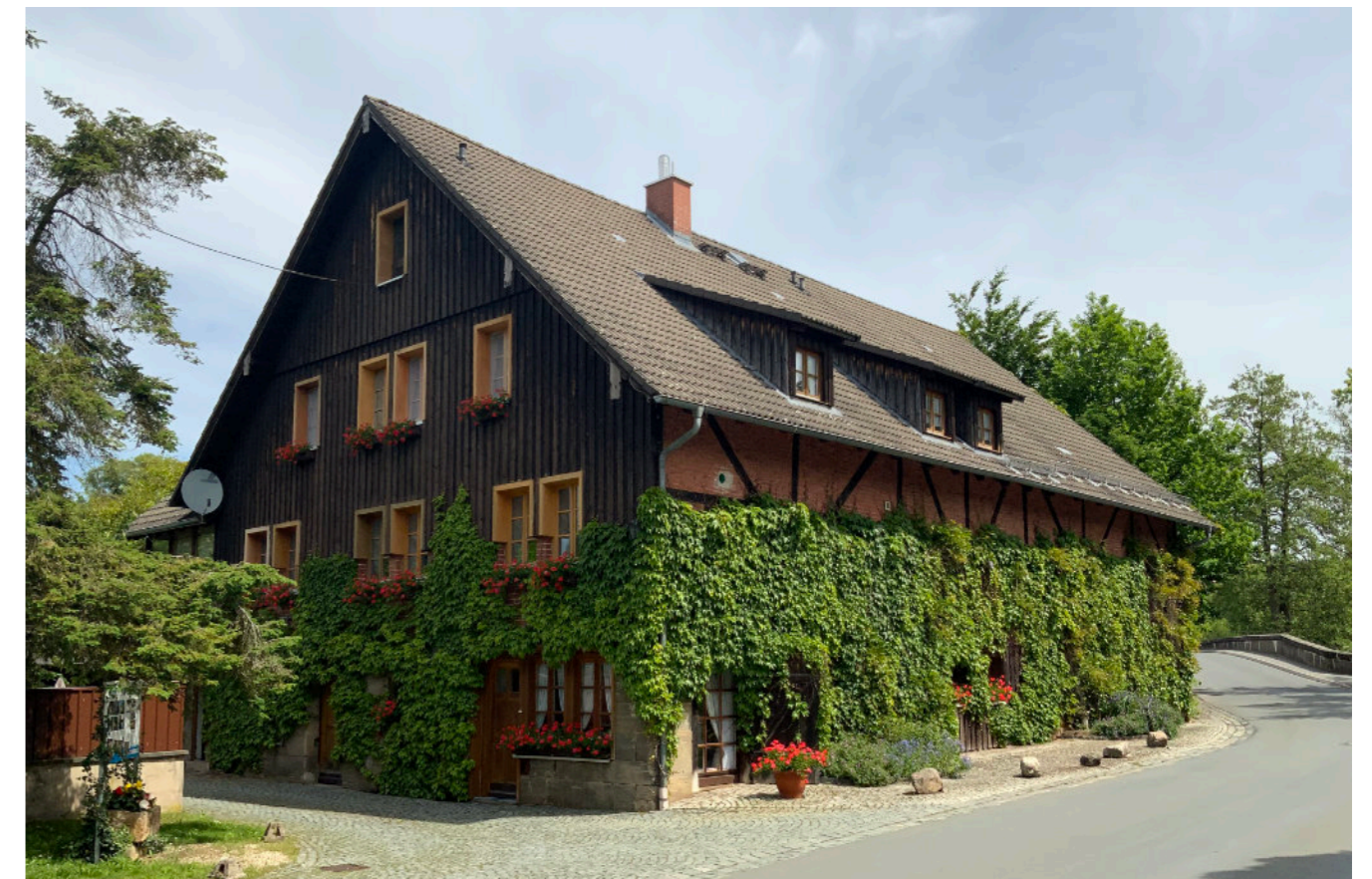
Abb. 5.6. In den 1990er Jahren zum Wohnhaus umgebaute Scheune (Altdrossenfeld Ia)
