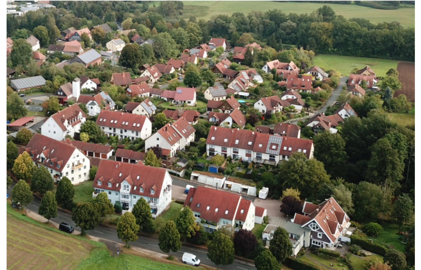
Abb. 2.X. Schrägaufsicht auf verschiedene Gebäudetypen in Altdrossenfeld
