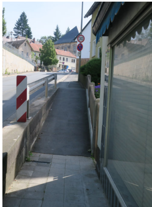
Abb. 5.7. Seitenbereich Bayreuther Straße (Nr. 5), steile Rampe
